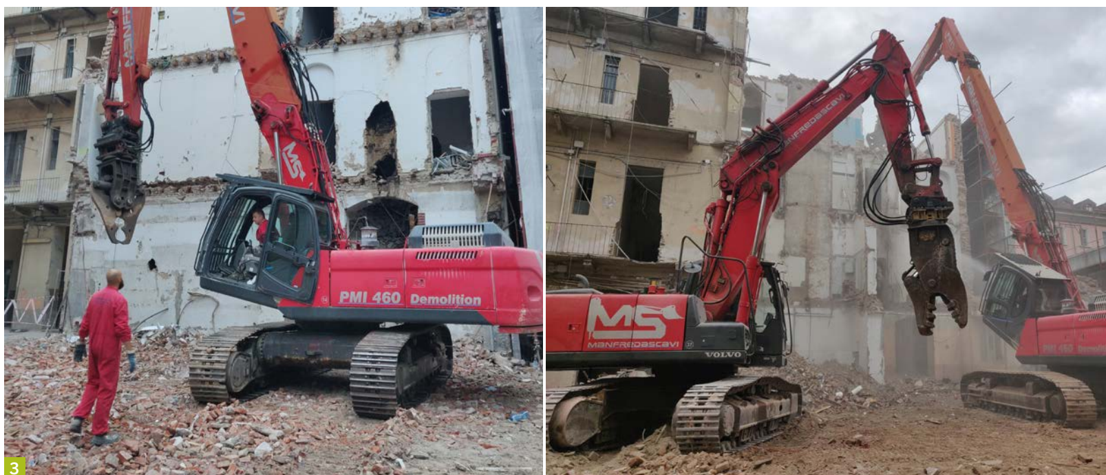
3. Le opere di demolizione dei corpi di fabbrica sono state affidate a un escavatore cingolato PMI 460 con braccio speciale da demolizione e pinza frantumatrice, affiancato da un escavatore cingolato Volvo EC235 NL.
